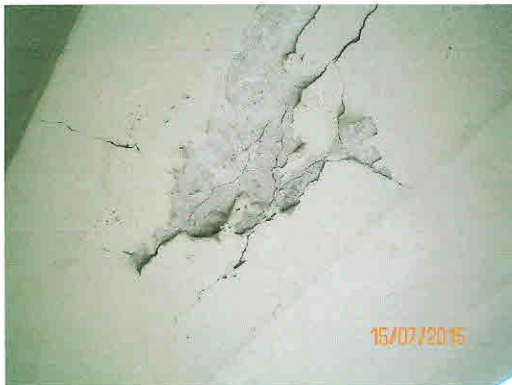
Bild 18: Rissgruppe, ungleichmäßig, Unterseite UPR
