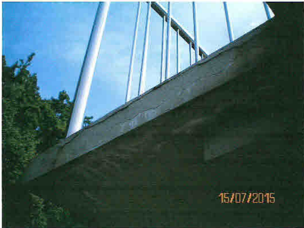
Bild 29: Podestplattenrand, Vertikal-u.Horizontalsisse
