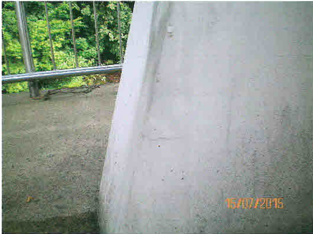
Bild 21: Einzelrisse, horizontal an Stielinnenseite, ISL
