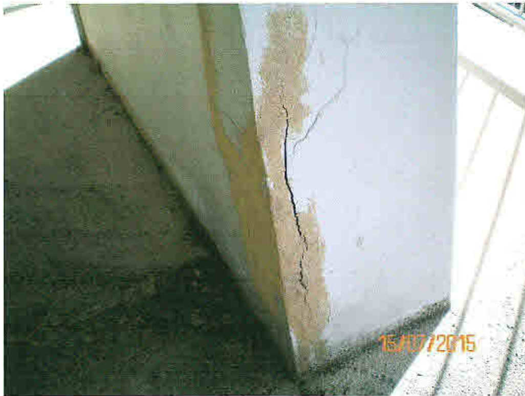
Bild 17: Aufplatzung Stiel + 5,50 Innenseite ISR
