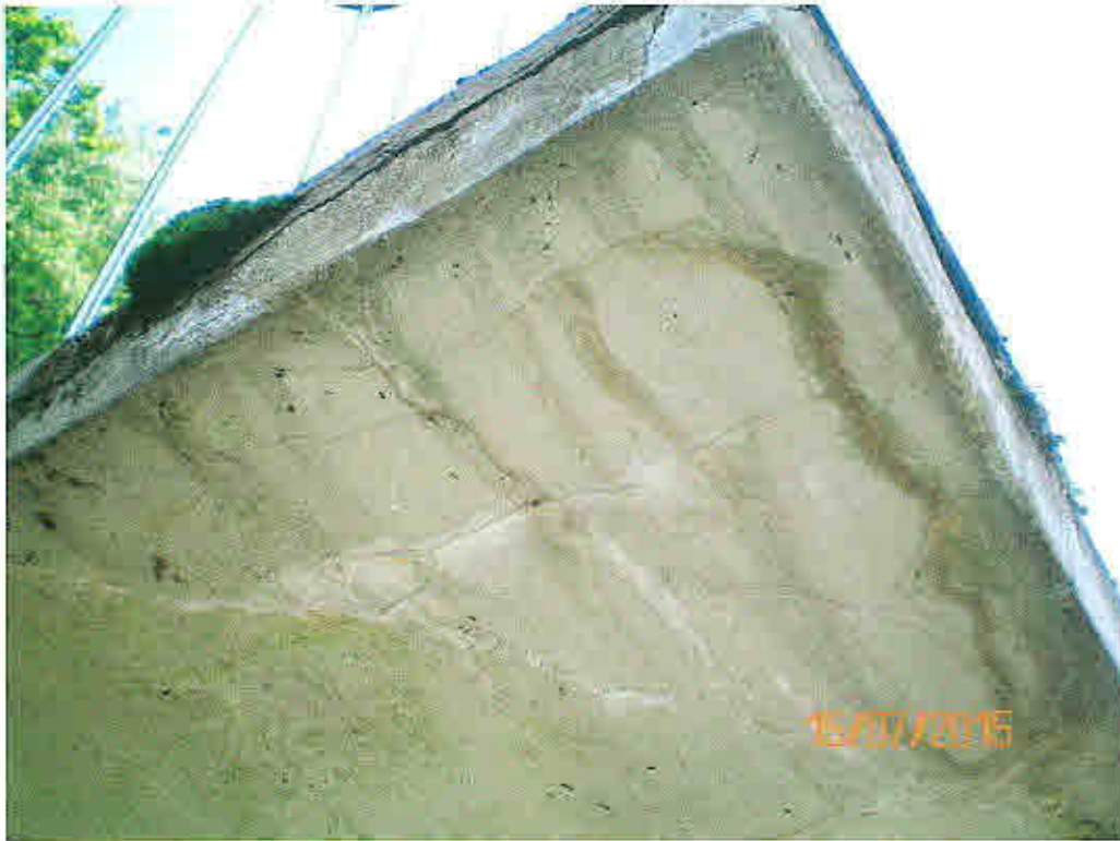
Bild 27: Podestplattenecke, Rissanhäufung,
