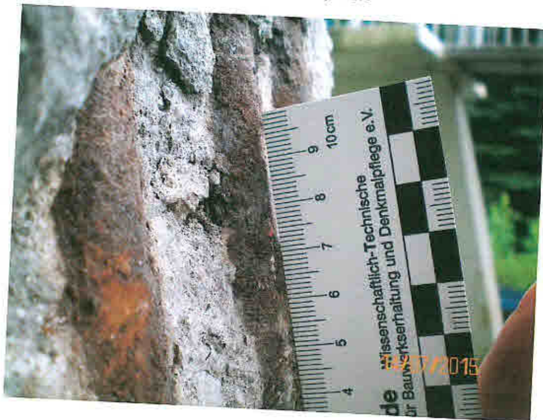
Bild 6: Abgelöste Rostschichtdicke, OSR
