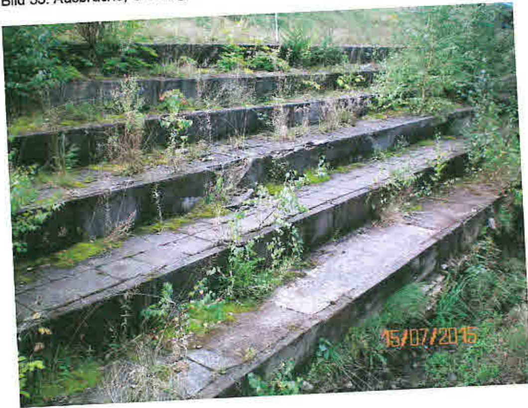
Bild 54: Bodenförmiger Horizontalverschub
