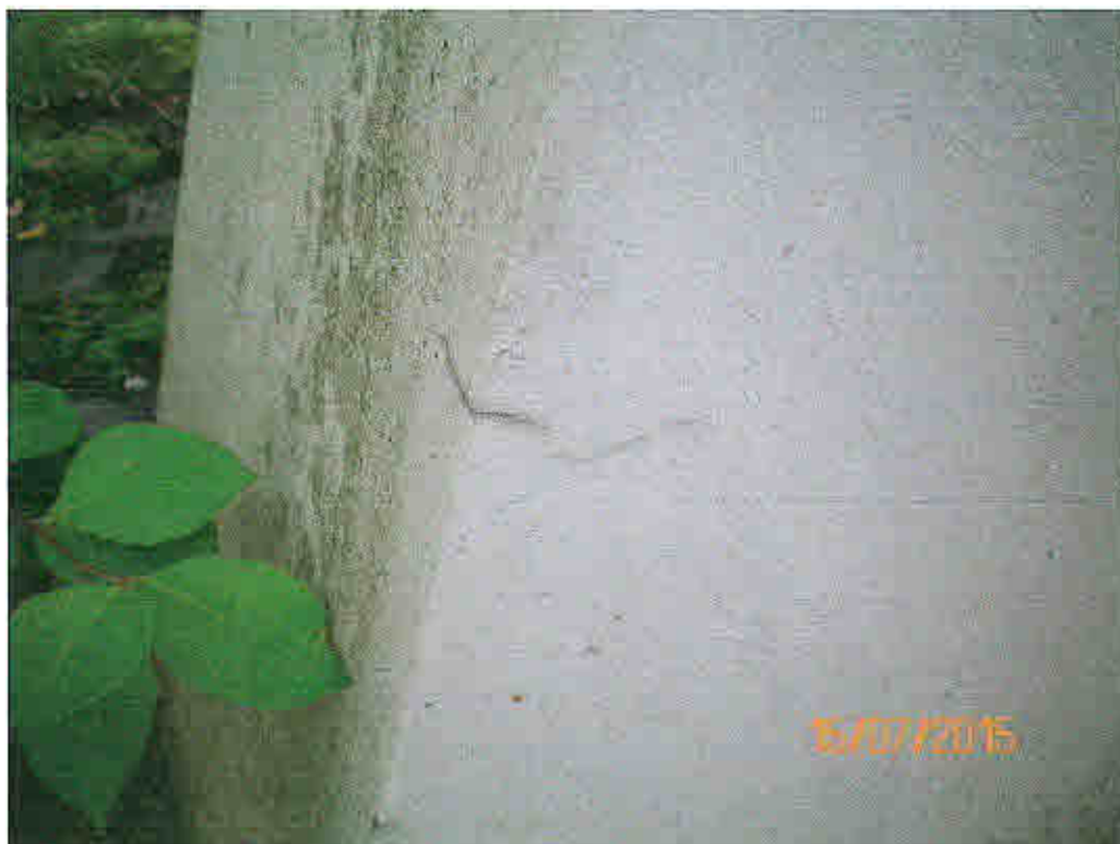
Bild 22: Einzelrisse, über Eck, ISL
