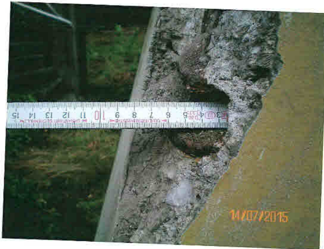
Bild 10: Detail Betonfehlstelle 2, Ecke OSR/ISR
