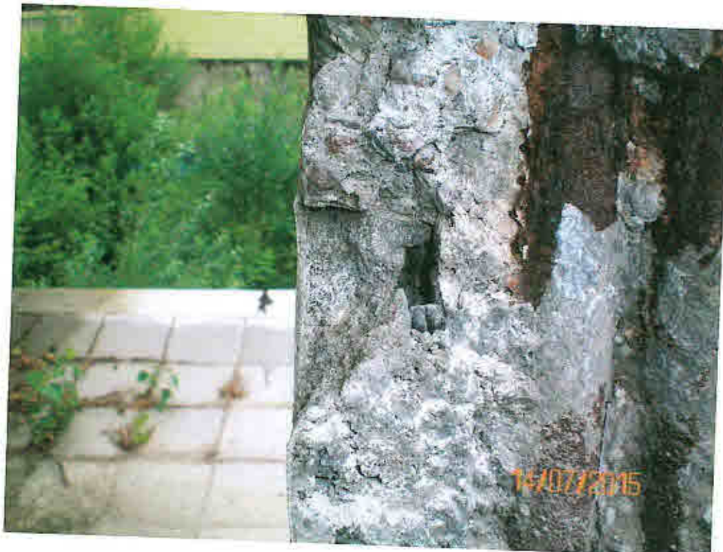
Bild 10: Detail Betonfehlstelle 2, Ecke OSR/ISR
