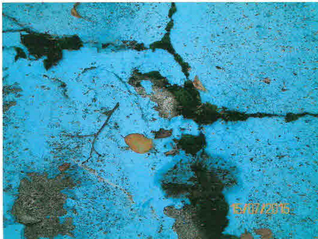
Bild 46: Bodenplatte, Risse
