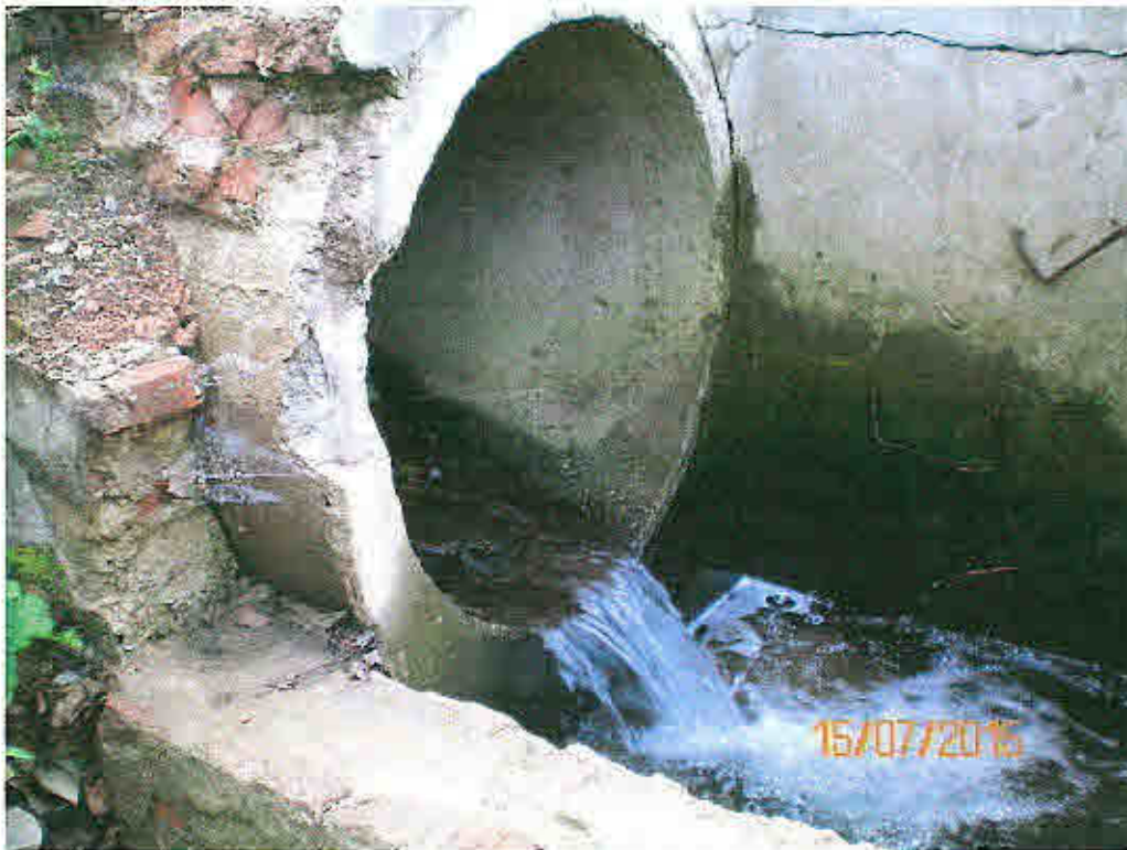
Bild 55: Verrohrung Gansbach unter den Traversen
