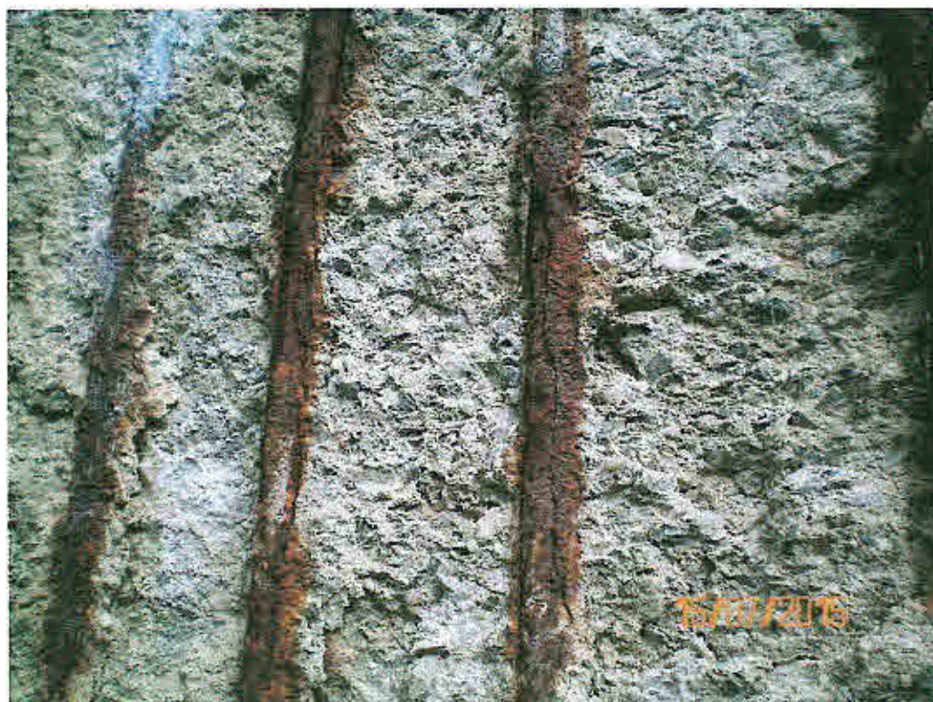
Bild 36: Korrodierte Haupt-Bewehrung
